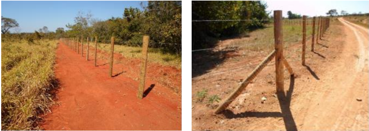
Figura 13: Cercas construídas em projetos hidroambientais na Bacia do Rio São Francisco
